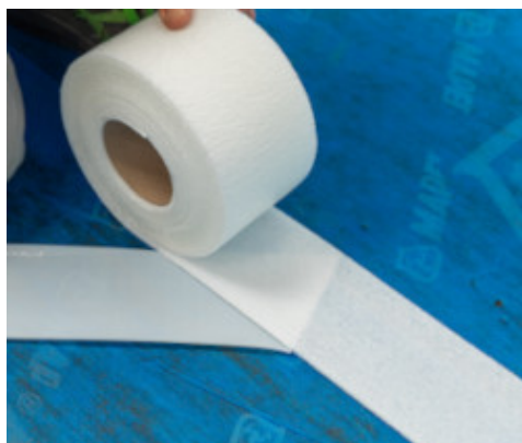
Sigillatura delle sovrapposizioni o delle giunzioni.
