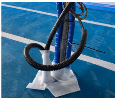
Sigillatura dei corpi passanti.
