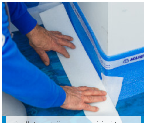
Sigillatura delle sovrapposizioni tra membrana fonoisolante e fascia perimetrale.
